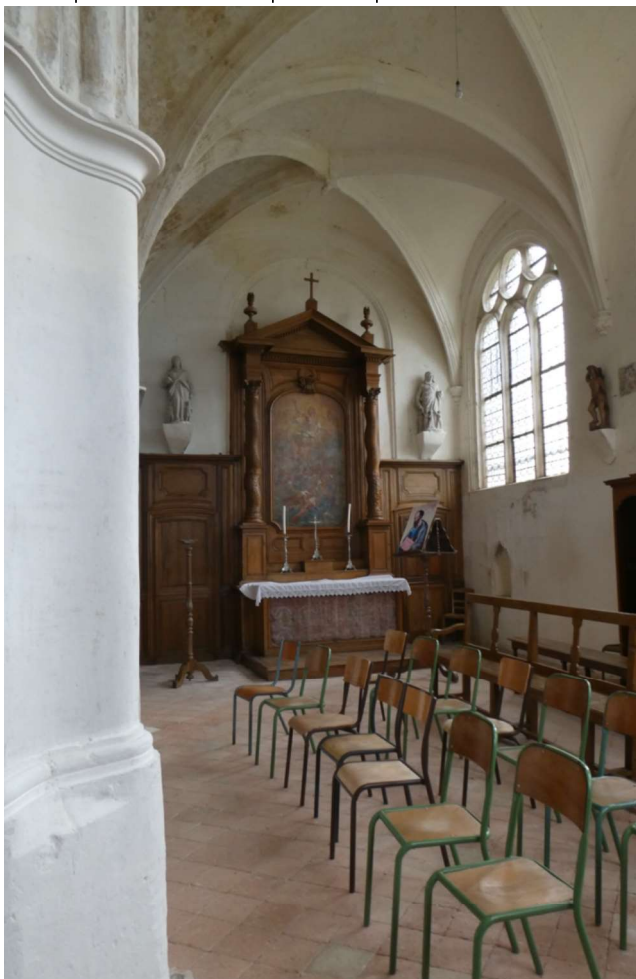
Vue sur les 2 travée Est de la chapelle Sud
