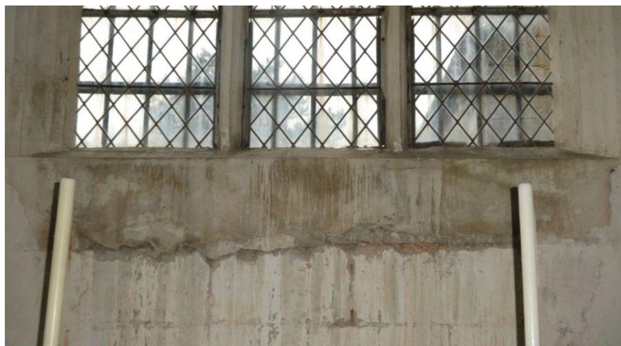
Appui refait au ciment sur la baie n°8
