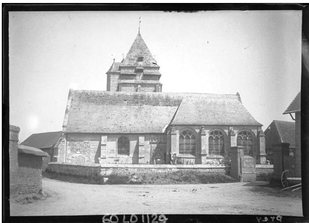
Élévation Sud de l'église, avant la première guerre mondiale (absence de monument aux mort)
