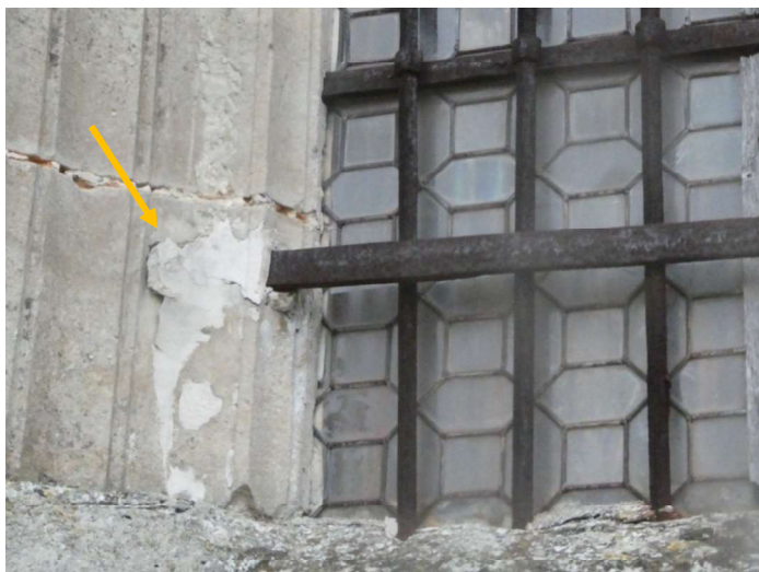
Entailles bouchées au plâtre pour l'ajout des traverses horizontales
