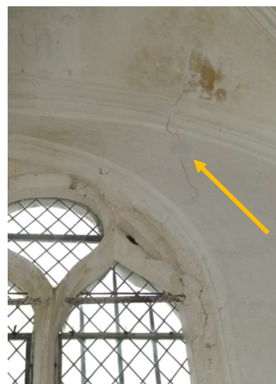
Infiltrations anciennes depuis le toit sur les voûtes et l'arc formeret des baies n°6 (à gauche) et 8 (à droite)
