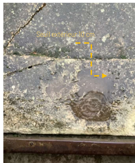
Seuil extérieur de 10 cm de hauteur
