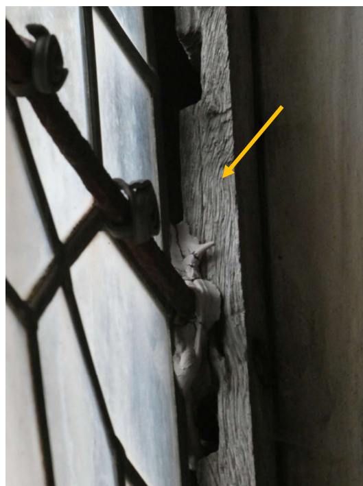
Calfeutrement assuré par une planche de bois
