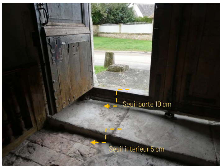
Seuil intérieur de 5cm de hauteur + seuil de la porte
