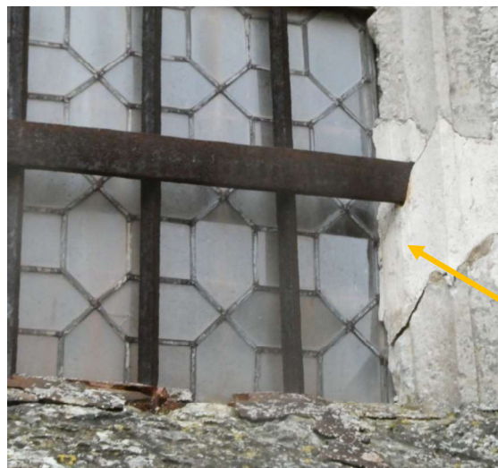
Entailles bouchées au plâtre pour l'ajout des traverses horizontales
