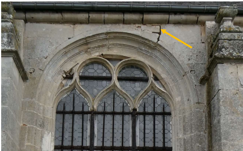
Infiltrations anciennes depuis le toit sur les voûtes et l'arc des baies n°6 (à gauche) et 8 (à droite)
